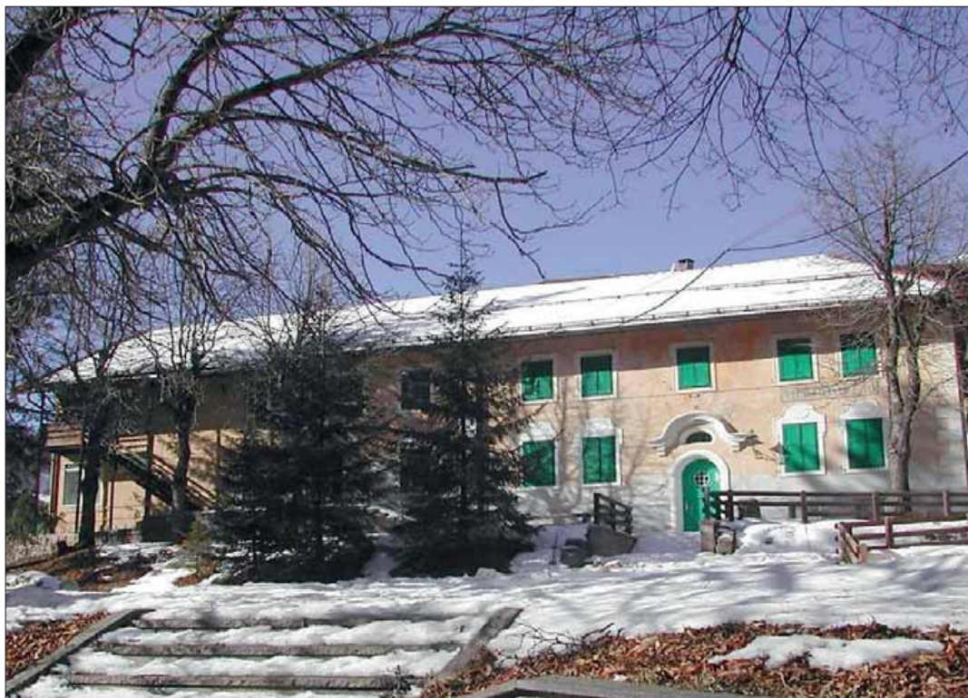
La nuova sede del Comun General sorgerà nell'area dell'ex caserma "Vittorio Veneto" (nella foto) che dovrà essere demolita e ricostruita
